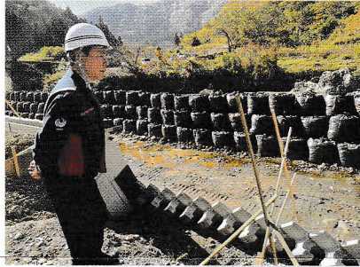
高時川災害復旧現場
